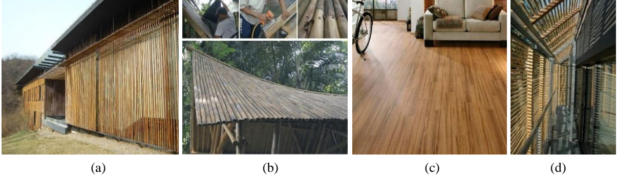
Şekil 4.3 (a) Bambu duvar kaplaması (John, 2014), (b) Bambu çatı kaplaması (Cortés, 2021), (c) Bambu zemin kaplaması (Admin. b.t.), Bina dış cephe gölgeleme elemanı olarak bambu kullanımı (Treehugger, 2012)
