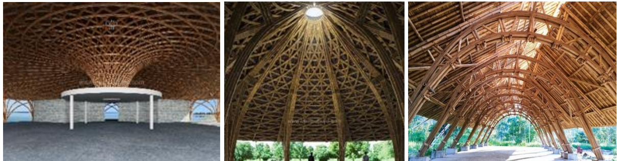
Şekil 4.2 Çeşitli yapılarda strüktürde farklı yöntemlerle bambu kullanımı ('Bamboo structure', b.t.)
